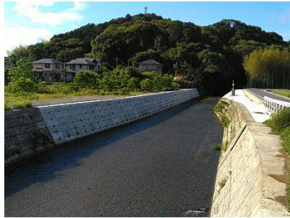
護岸工（右岸側より）
