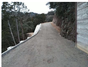
進入路(起点側)
