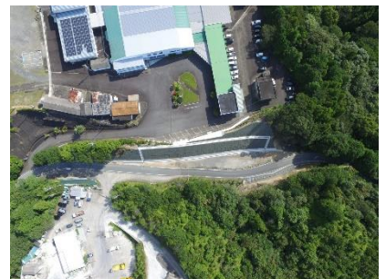
着工後（ドローンで撮影）
