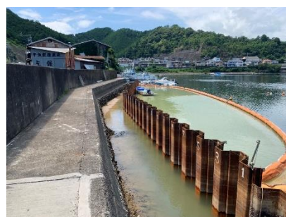
鋼矢板打設完了
