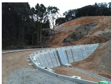
コンクリートブロック積工
