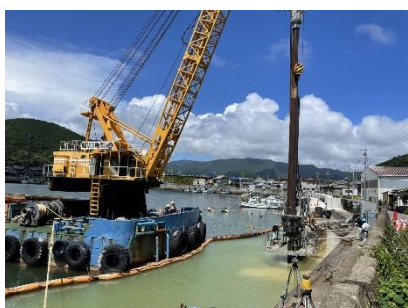
鋼矢板打設状況
