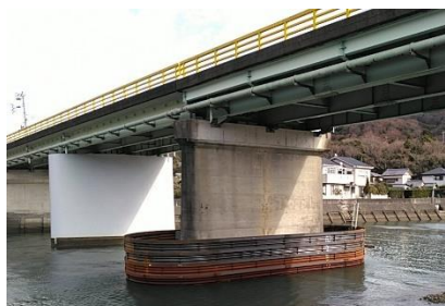
施工中 仮締切完了
