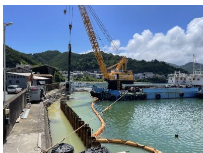
自社起重機船「第18亀川丸」
