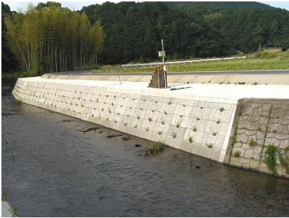
コンクリートブロック積工
