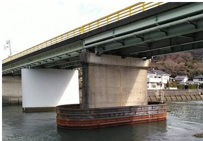
施工中 仮締切完了
