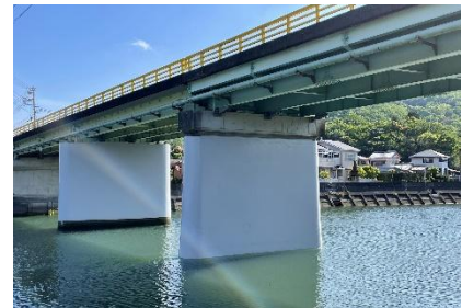
完成（近鉄船津駅側より）
