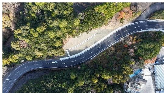
着工後（ドローン撮影）
