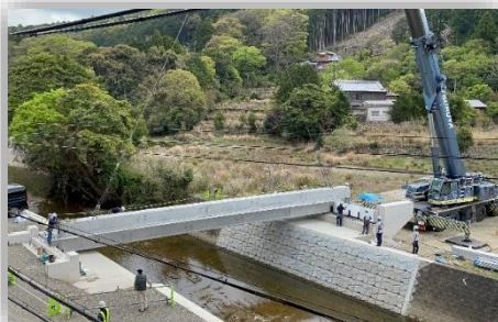
新しい橋を架ける工事 河内ダム工事用道路（その4）
