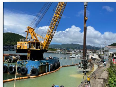
作業船 第18亀川丸 護岸工事での鋼矢板打設作業
